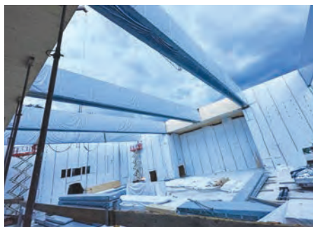
Z montažo strešnih nosilcev so izvajalci pohiteli in jo končali 3. avgusta, ko je bilo že objavljeno opozorilo pred poplavi in so se na nebu že zbirali temni oblaki.
