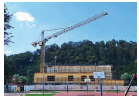
V času nastajanja tega prispevka je na gradbišču nove športne dvorane delalo kar pet ekip, in sicer so delavci izdelovali izolacijo, fasado, termoizolacijo, nanašali algicid in vgrajevali stavbno pohištvo.
